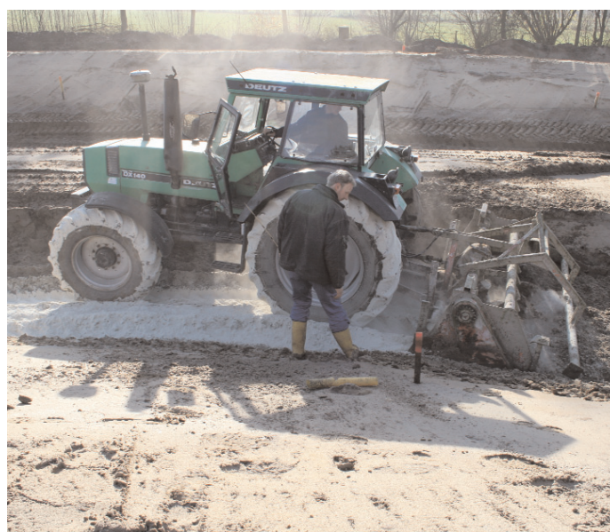
Bild 4: Bodenfräse im Einsatz
