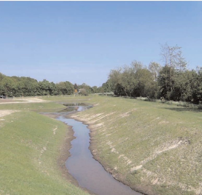
Bild 5: Regenrückhaltebecken Dorfbach mit Restregelmengen
